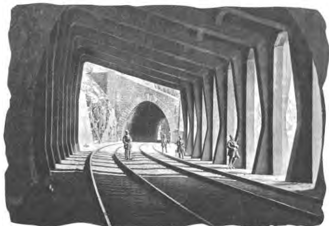
Чехословацкие бойцы охраняют тоннель Кругобайкалки, 1920 г.
