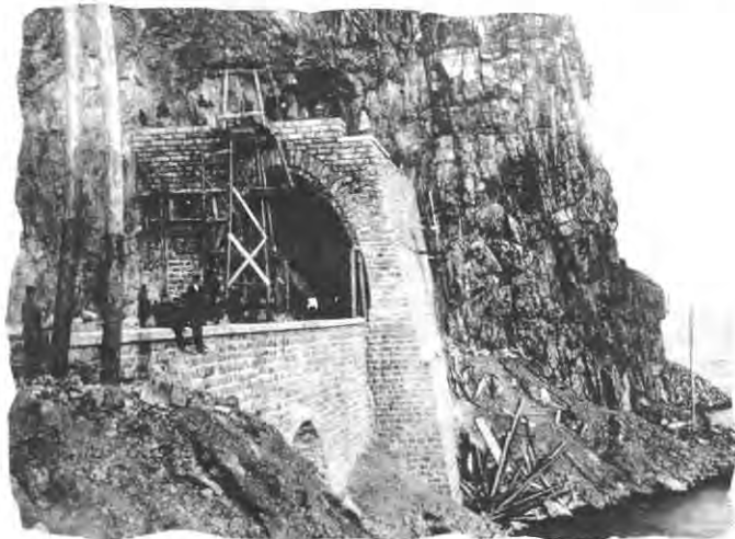
Строительство комплекса тоннеля № 25 («Тоннель с ногой», длина – 116,8 м)
