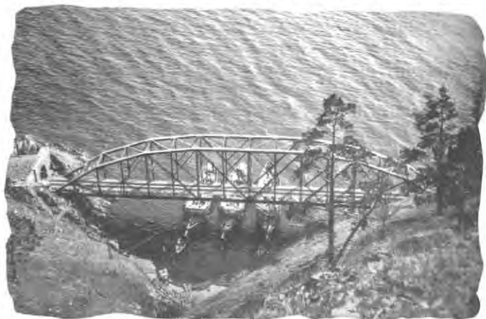
Установка моста через бухту Березовая, 1904 г.
