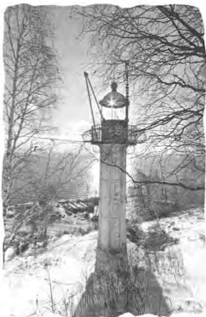
10-метровый маяк установлен в порту Байкал в 1900 г. Изготовлен в Англии на заводе «Сэр В.Г. Армстронг, Витворт и К°», находящемся в Ньюкастле, из такой же сименс-мартеновской стали, что и ледоколы «Байкал» и «Ангара». Сохранился до нашего времени
